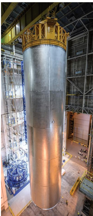
Рисунок 5. Общий вид демонтажа с вертикального монтажного центра после окончательной сварки методом СТП бака жидкого водорода для SLS
