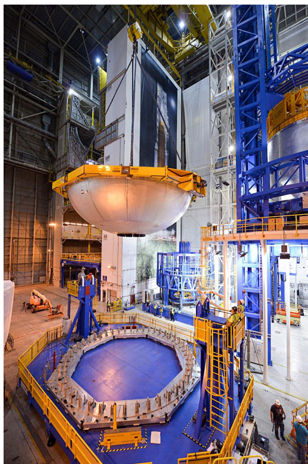
Рисунок 6. Общий вид монтажного центра (на переднем плане - оборудование для изготовления днищ, справа - вертикальный монтажный центр)
