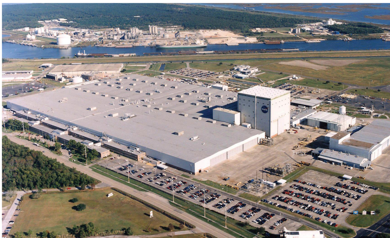
Рисунок 3. Общий вид Michoud Assembly Facility
